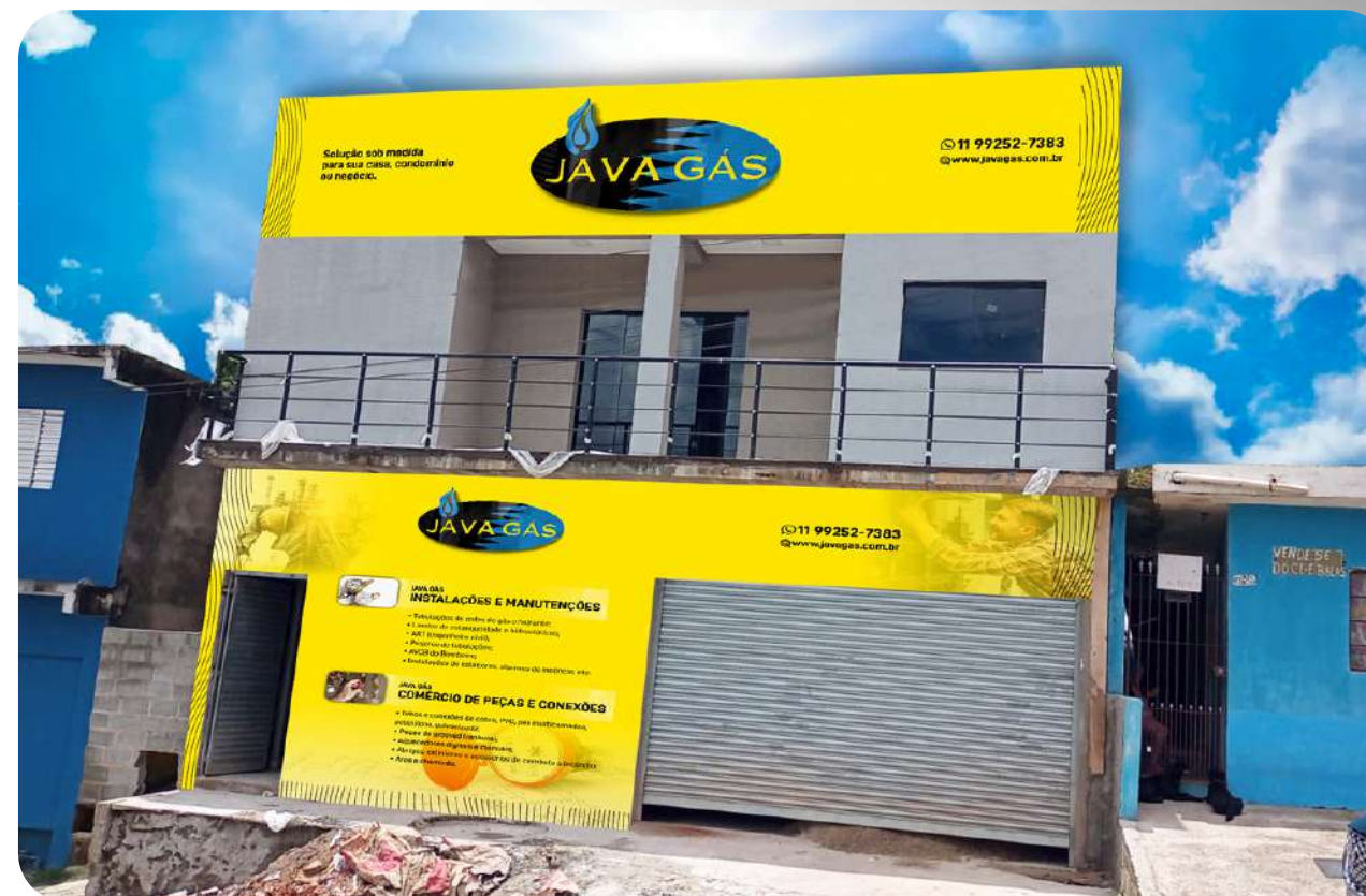
Cobertura em ACM
